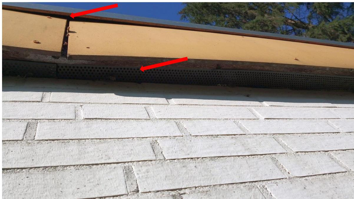
Abb. 5:Nebengebäude mit Flachdach: Vergitterung und Spalte in der Dachkante
